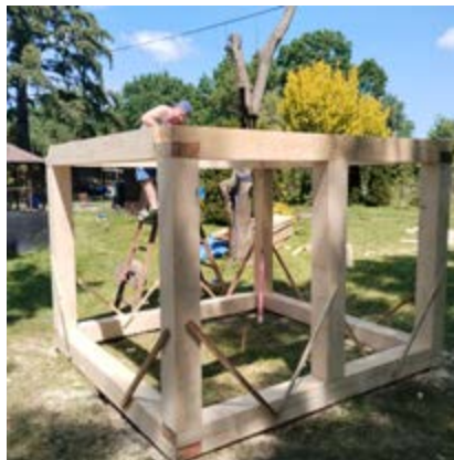
▲ Stavba obvodových rámců
